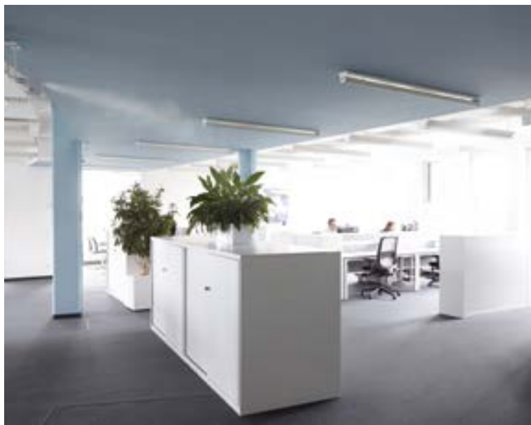
Befeuchten in einem Büro
